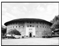
A. 福建土楼
